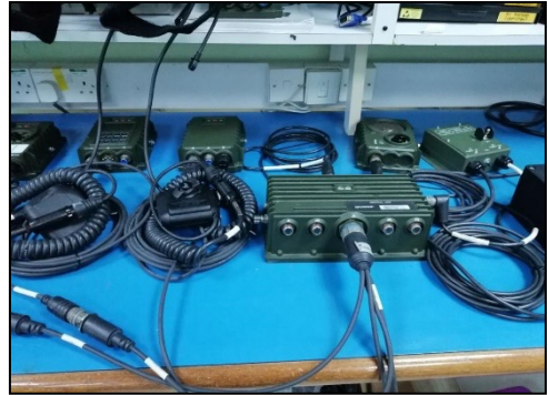
Rajah 12: Sebelum pemasangan.
